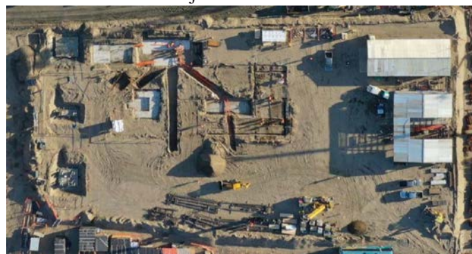
Figura 1: Foto aérea de la plataforma de la obra
