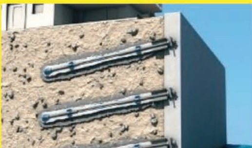
Retrofijación de tablestacas
