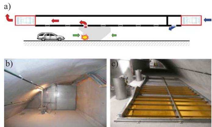
Figura 23: Túnel de Katschberg, Austria: a) instalación de toberas Saccardo en túneles existentes para controlar la corriente de aire en el túnel, b) muro de separación y c) inyección de aire fresco (Sturm *et al.*, 2014, 2017).
