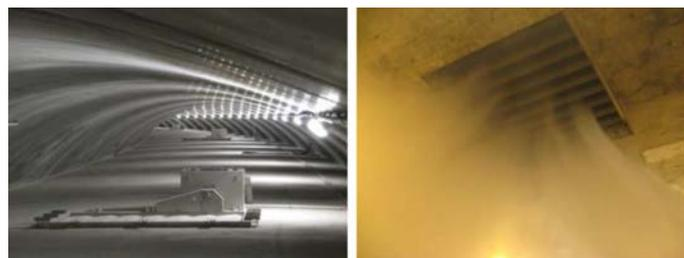
Figura 16: Exutorio de acero en un túnel, resistencia 400 °C durante 120 min (Warenzeichenverband Edelstahl Rostfrei/Sirocco Luft- und Umwelttechnik, tunnel-online.info 2015)
