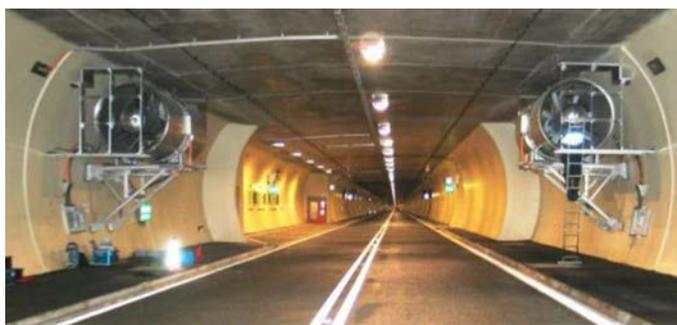
Figura 22: Túnel de Bosruck, Austria. Instalación de 8 grandes *jet-fans* de 2700 N cada uno en 4 nichos de ventilación en lugar de los 40 *jet-fans* que hubieran sido necesarios para cada tubo (Sturm *et al.*, 2017)
