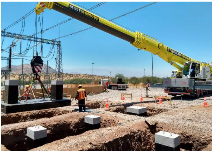
Ilustración 2: Montaje fundaciones prefabricadas Prefast ([www.prefast.cl/proyectos/ing-agrosonda-spa](http://www.prefast.cl/proyectos/ing-agrosonda-spa))
