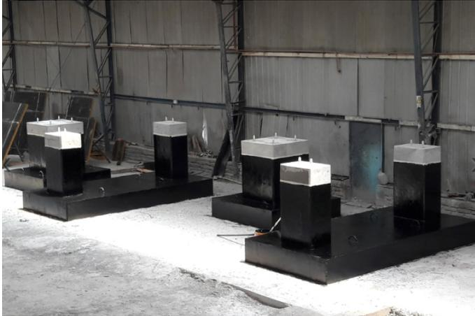
Ilustración 1: Fundaciones prefabricadas Prefast ([www.prefast.cl/proyectos/ing-agrosonda-spa](http://www.prefast.cl/proyectos/ing-agrosonda-spa))
