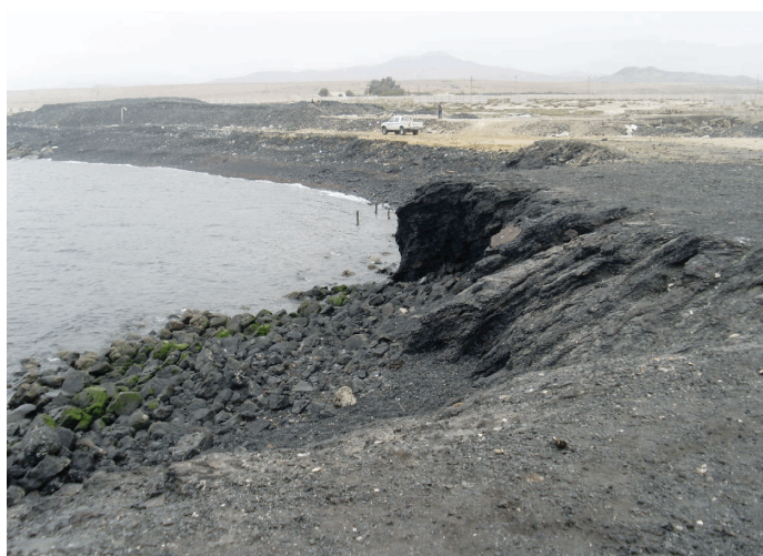
Figura 2: Vista actual del vertedero abandonado de escorias de cobre (color oscuro) en Caldera.
