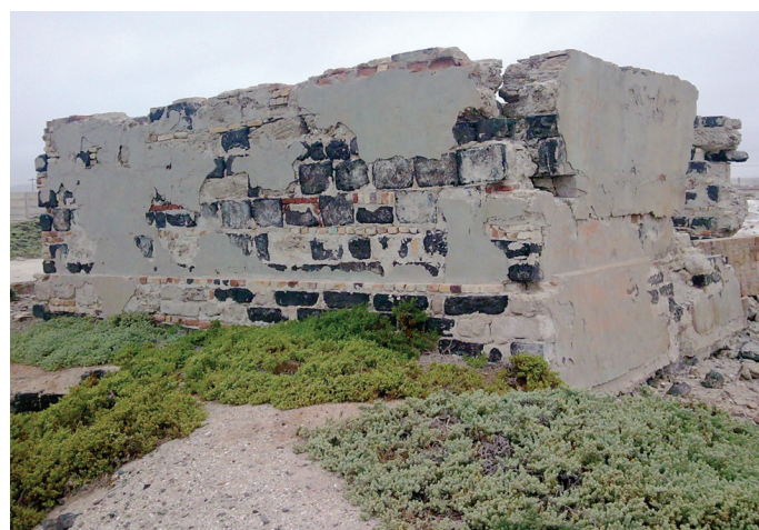
Figura 7: Estructura en la Zona 2, cuenta con 2 muros interiores en perpendicular, formando 4 secciones cerradas
