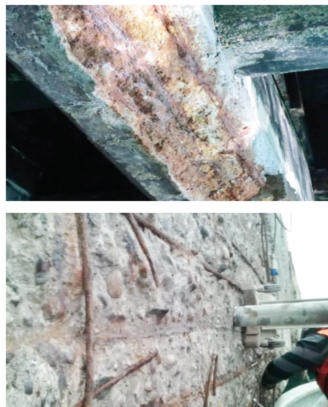
Figura 1: Deterioro por efecto de corrosión en estructuras portuarias
