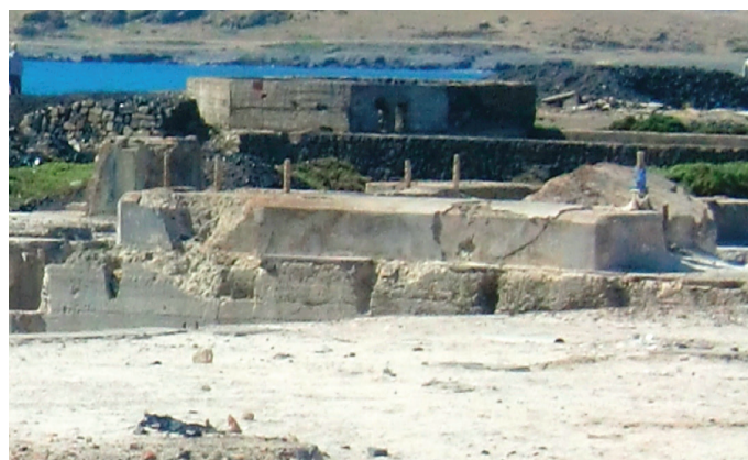
Figura 8: Fundaciones de hormigón en la Zona 3
