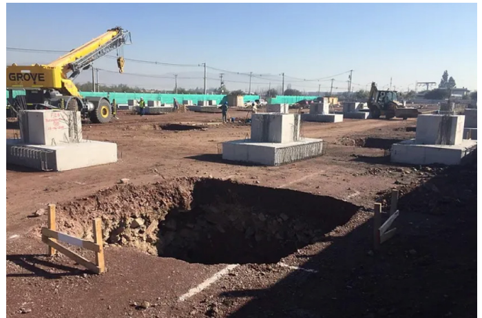
Ilustración 3: Fundaciones centro de distribución Buenaventura. ( www.tensocret.cl )
