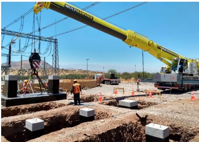
Ilustración 2: Montaje fundaciones prefabricadas Prefast ( www.prefast.cl/proyectos/ing-agrosonda-spa )
